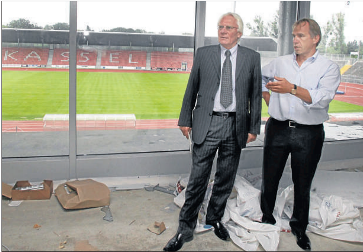
Besichtigten die Baustelle: Ministerialdirigent Prof. Heinz Zielinski (links) ließ sich von Jens Rose (KSV-Vorstand) den VIP-Bereich auf der neuen Haupttribüne zeigen.
