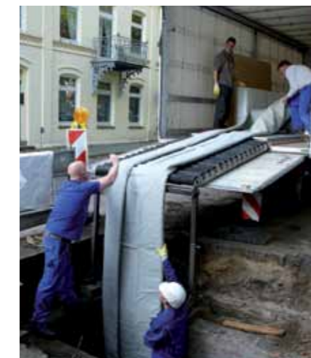
Fotos: Rainer Kiel Kanalsanierung GmbH
